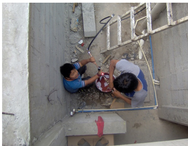
Figura 87. Taller práctico de instalaciones 3. Archivo personal, 2006.
