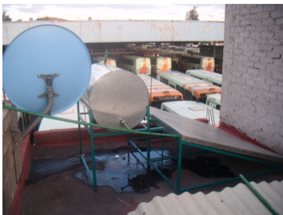
Figura 110. Prototipo de calentador solar. Archivo personal, 2010.
