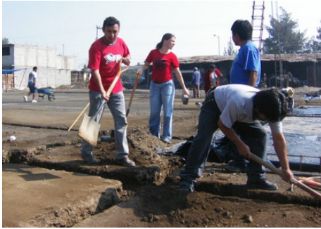
Figura 56. Trabajos comunitarios para la cimentación 2. Archivo personal, 2006.
