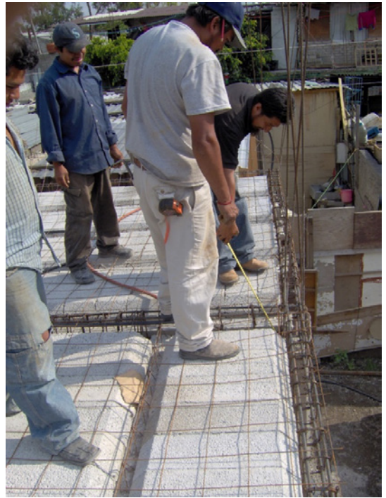
Figura 99. Verificando amarres de estructura. Archivo personal, 2006.
