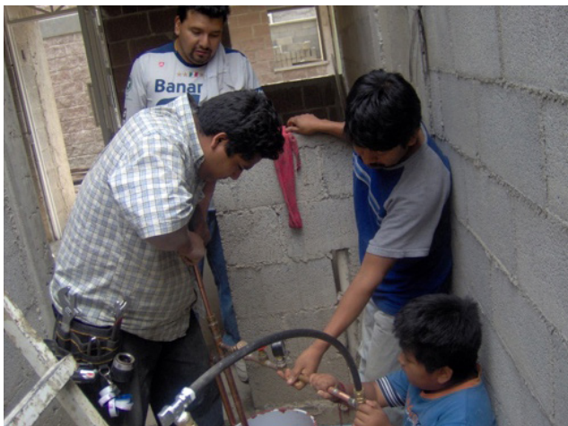
Figura 86. Taller práctico de instalaciones 2. Archivo personal, 2006.
