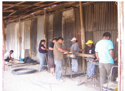
Figura 59. Trabajos comunitarios para habilitar acero 1. Archivo personal, 2006.
