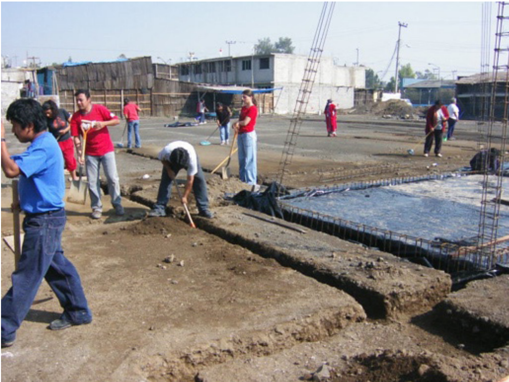
Figura 55. Trabajos comunitarios para la cimentación 1. Archivo personal, 2006.
