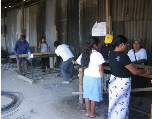
Figura 60. Trabajos comunitarios para habilitar acero 2. Archivo personal, 2006.
