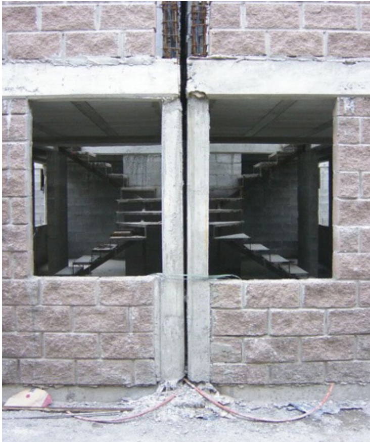
Figura 103. Vista de escaleras. Archivo personal, 2006.
