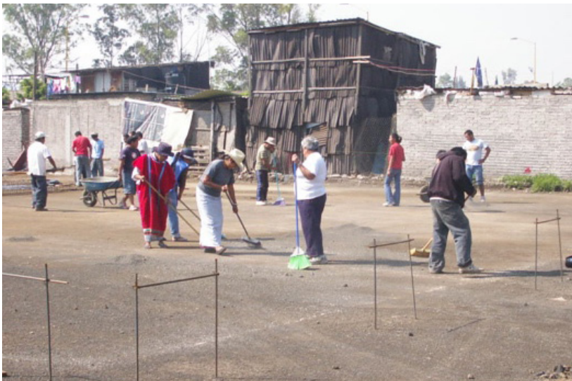
Figura 57. Trabajos comunitarios para la cimentación 3. Archivo personal, 2006.
