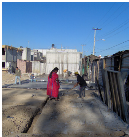
Figura 44. Excavación de cepas para cimentación. Archivo personal, 2006.
