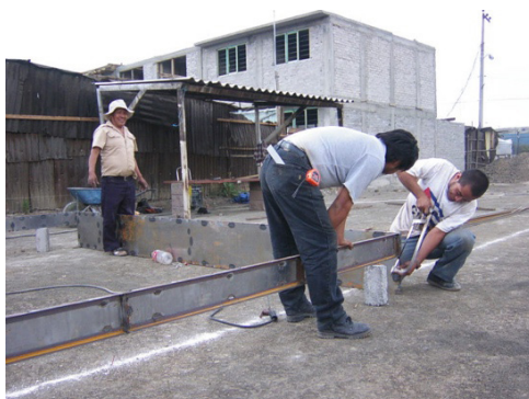
Figura 68. Habilitado de cimbra para cimentación. Archivo personal, 2006.
