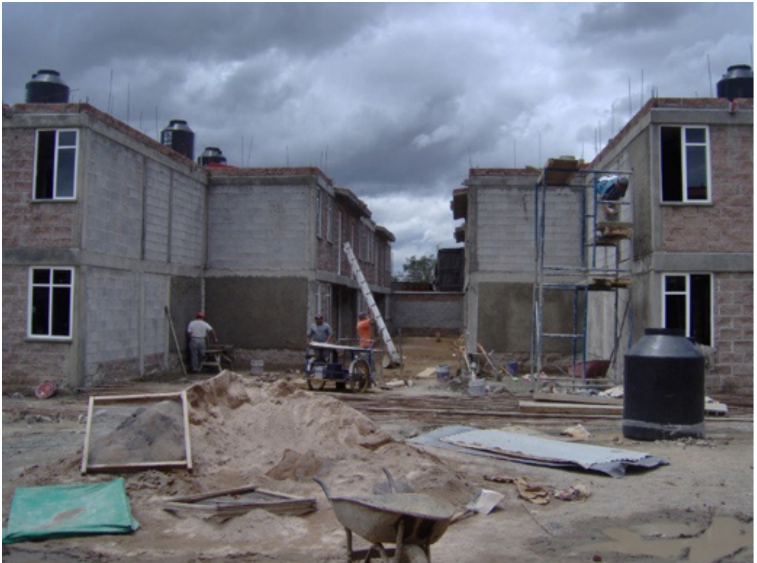
Figura 75. Aplanando muros exteriores. Archivo personal, 2006.
