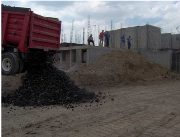
Figura 79. Mejoramiento de suelo en último bloque de viviendas Archivo personal, 2006.
