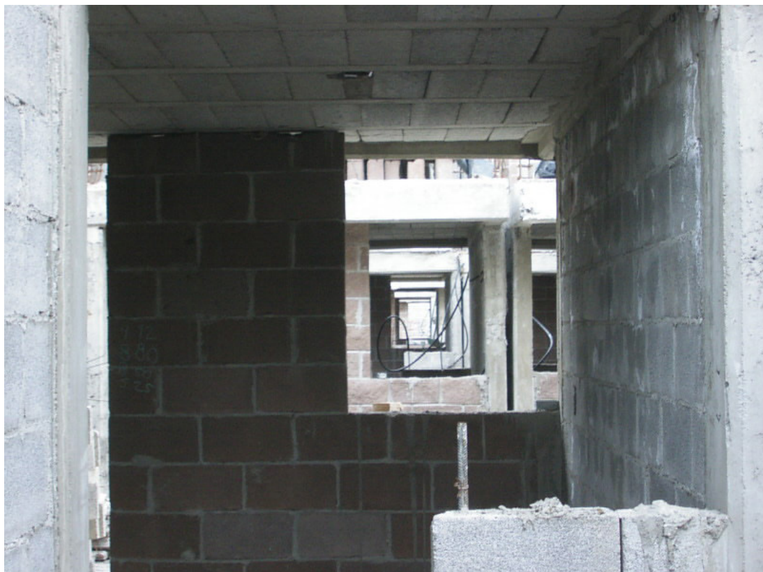
Figura 104. Vista de vanos. Archivo personal, 2006.
