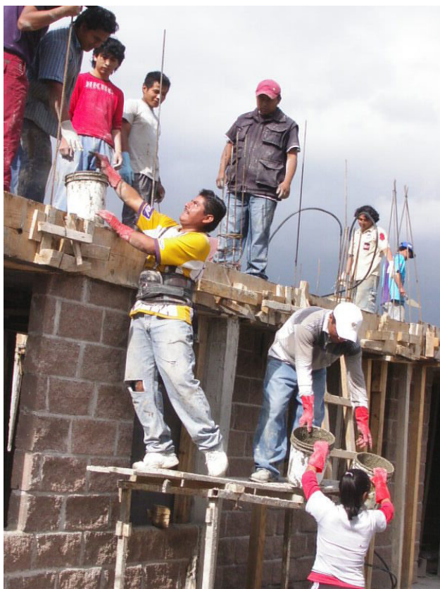
Figura 90. Colado comunitario de entrepisos. Archivo personal, 2006.
