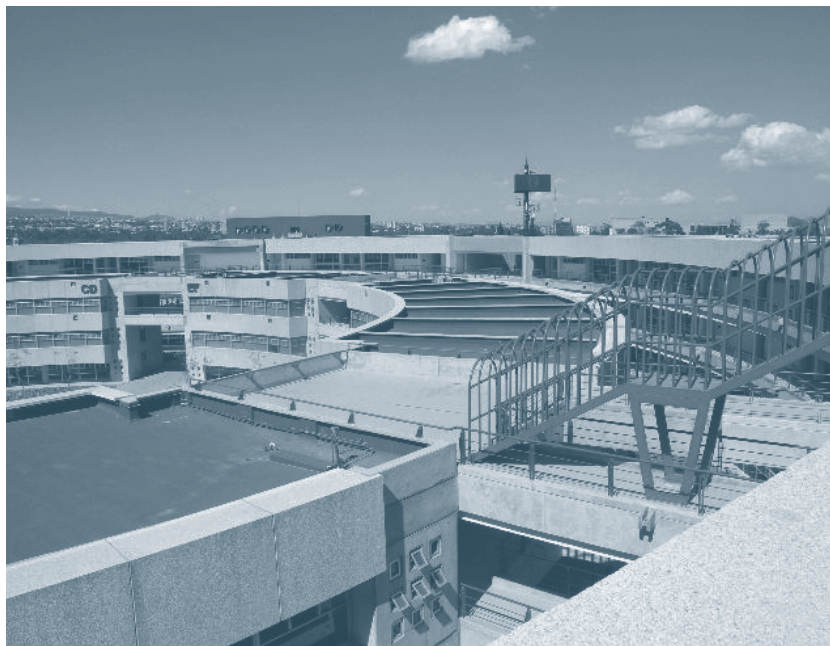
Figura 19. Escalera de servicio a los paneles solares del Posgrado en Diseño Industrial.
