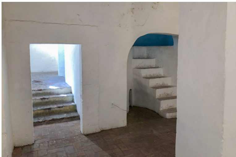
Foto 8. Calentador de agua en el antiguo convento de la Concepción en Antigua, Guatemala. Fuente: Pastrana (2015).
